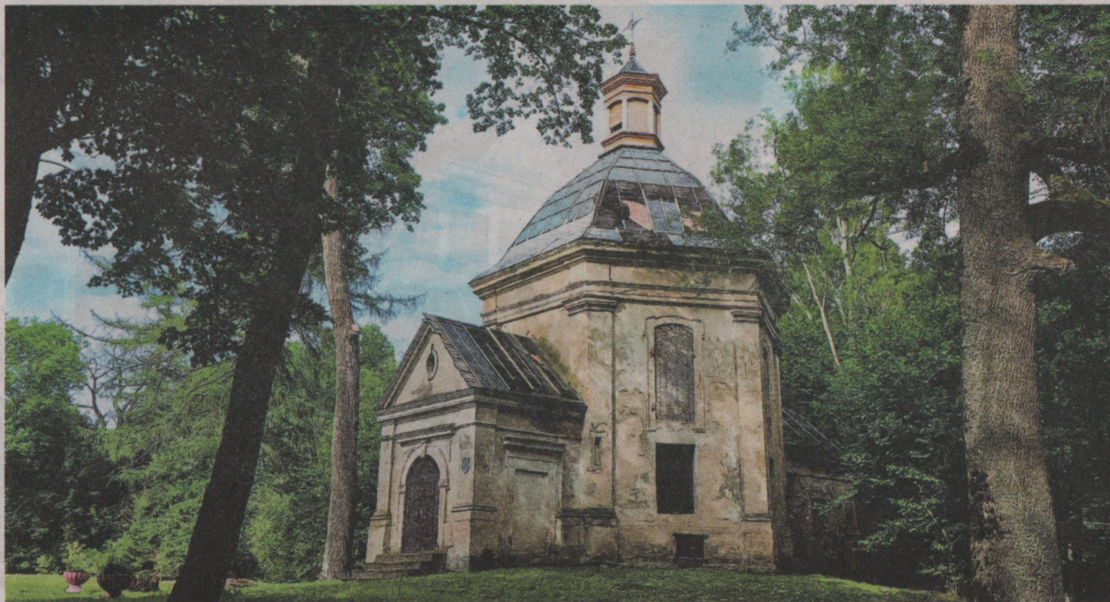
Часовня Воздвижения Креста Господня переживает очередное рождение – здесь ведется реконструкция.
