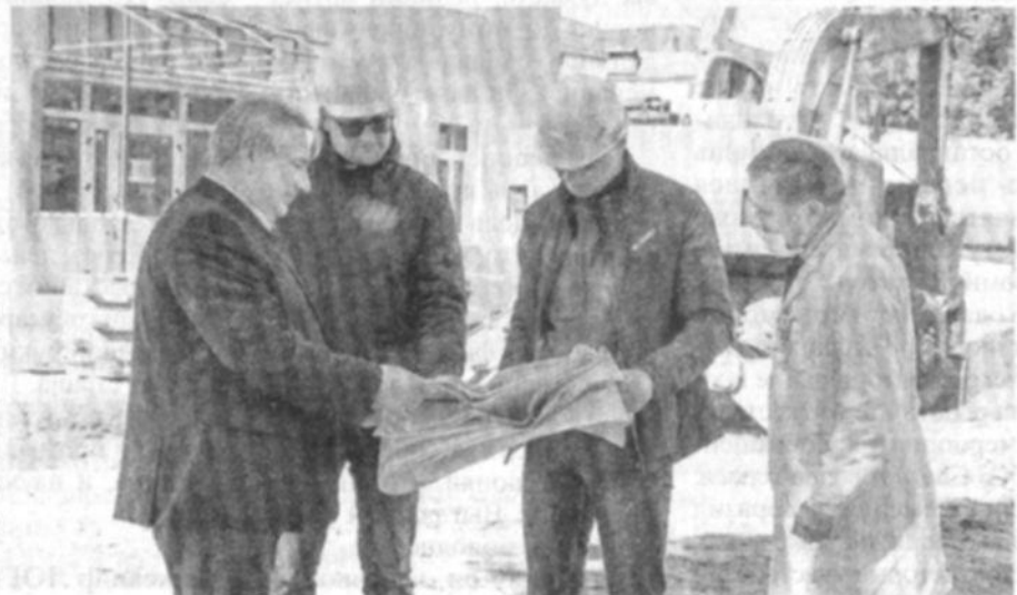
Александр Сацута (первый слева) на работах по реконструкции здания онкодиспансера
